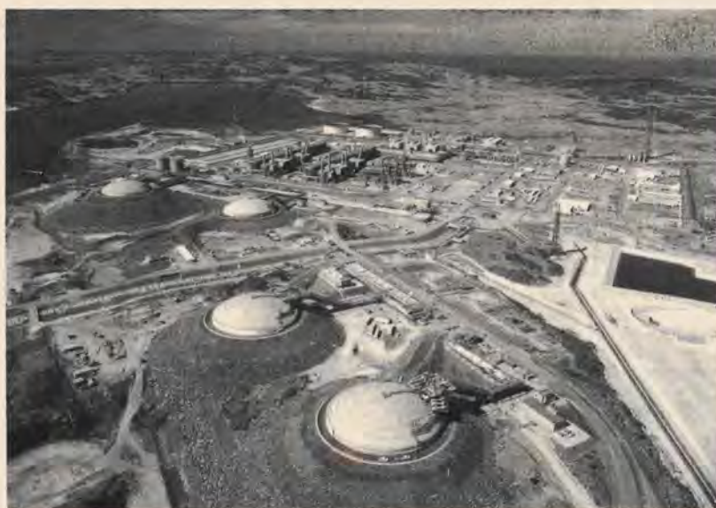
LNG plant, North West Shelf project
