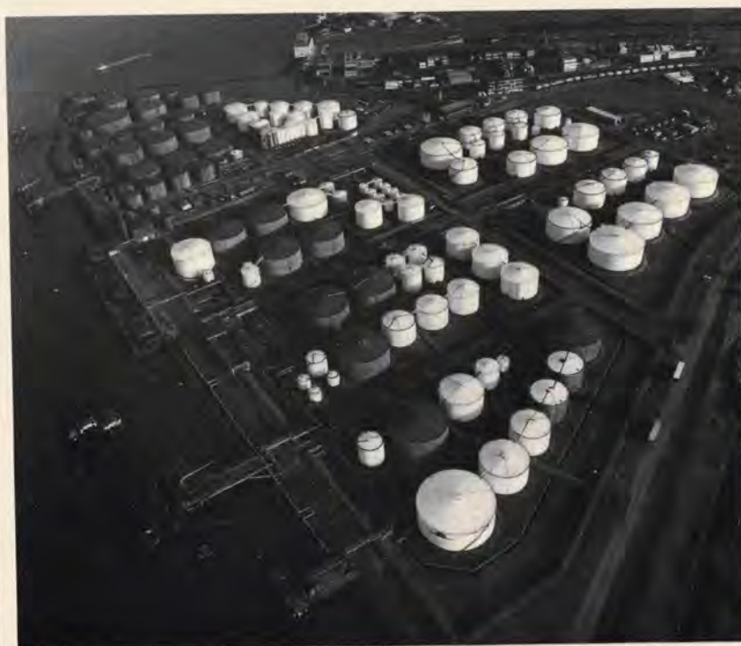
Paktank NOM Terminal.
