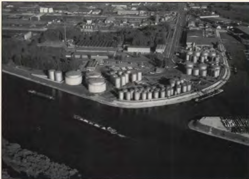
TLG Tanklager-Gesellschaft HOYER mbH – Mannheim terminal
