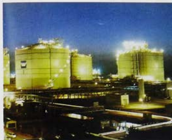
Pyongtaek LNG Terminal, Kogas, South Korea
